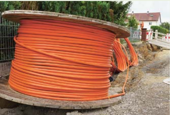
Der Glasfasernetzausbau in der Fläche ist aufwendig.
