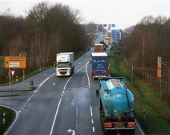
Flächenbeschaffung für den Ausbau der E 233
