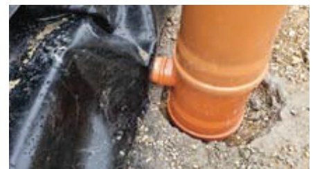
Überwachung kritischer Details beim Bau der Anlagen, hier Kontrollvorrichtung LES
