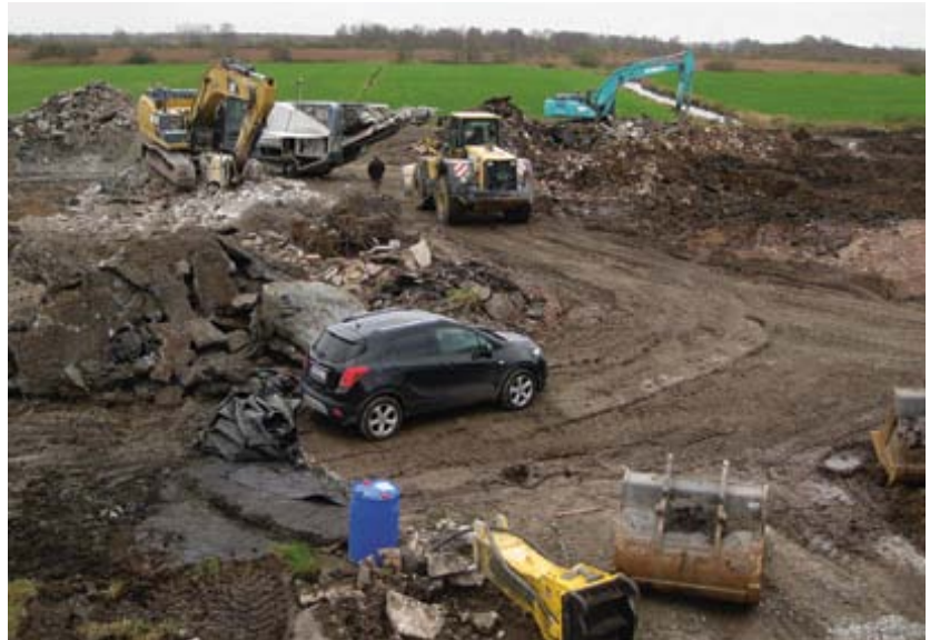
Abriss der Hofstelle und Entsiegelung
